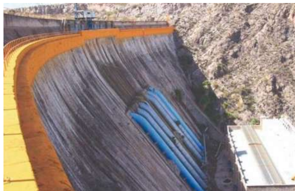
Presa “La Boquilla”
